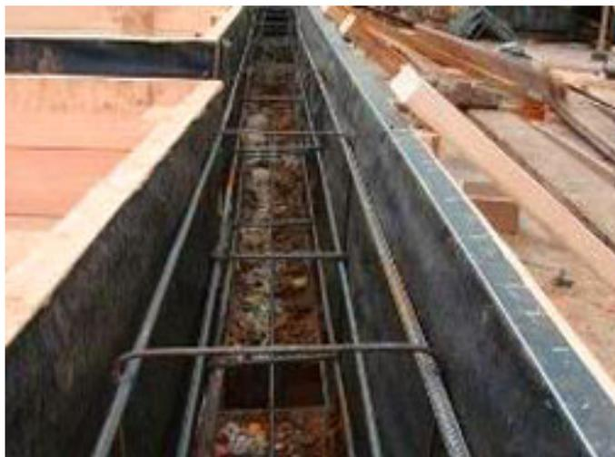
Для придания прочности фундаменту необходимо усилить его арматурой, превратив его таким образом в железобетон. Простой бетон хорошо воспринимает нагрузки, направленные на сжатие, но плохо – направленные на растяжение и изгиб.
