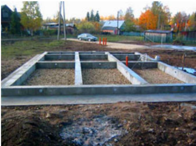
Если при укладке бетона в него добавляют камни (общей массой 30 — 40 % от массы бетона), то такой бетон называют бутобетоном. Прочность бутобетона такая же, как и бетона, но его применение значительно сокращает расход цемента, что сказывается на стоимости строительства.
